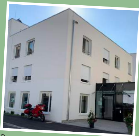
Das neue Haus in fast fertigem Zustand, fotografiert am 14. Sep.2021
